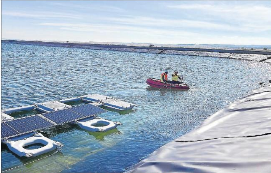
La bassa d'Alfés acollirà al voltant de 3.000 plaques solars amb una potència més de 2.000 kWn.
