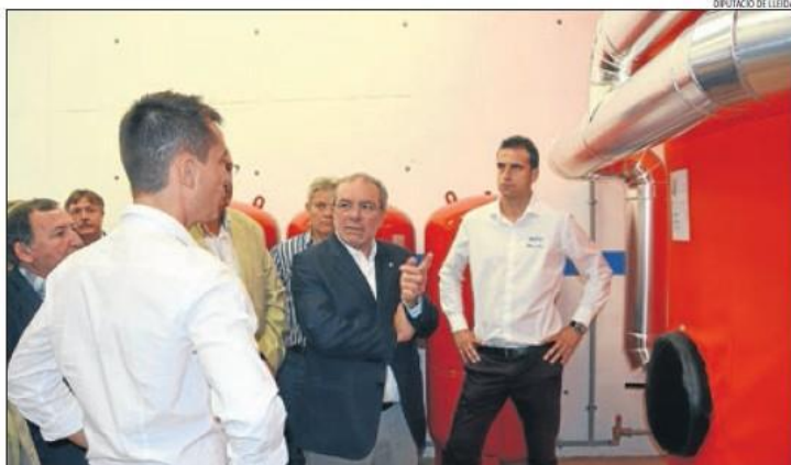
Reñé atén les explicacions dels responsables de la firma que ha instal·lat la caldera.
