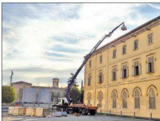
FOTO: UdL / La instalación se ha iniciado con la descarga del material
