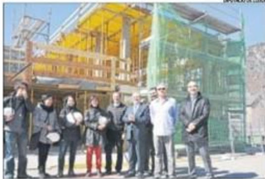
Visita de Reñé a les obres d'ampliació del CAP del Pont de Suert.
